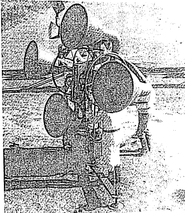
Das Horchgerät diente der akustischen Zielfindung. Es bestand aus vier Schalltrichtern, zwei für den Seiten und zwei für den Höhenwinkel. Die beiden Horcher konnten das Gerät rundum schwenken und 90 Grad hochkippen. Jeder Horcher trug eine Kappe mit Hörmuscheln für das rechte und linke Ohr. Um das Horchgerät wurde zur Abschirmung von Windgeräuschen ein 2,50 Meter hoher Käfig mit Jute-Bespannung gezogen. Foto: Bundesarchiv
